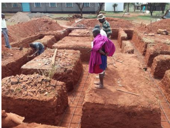
産科棟の土台の建設現場
