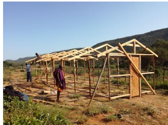
建設中の養蜂施設
