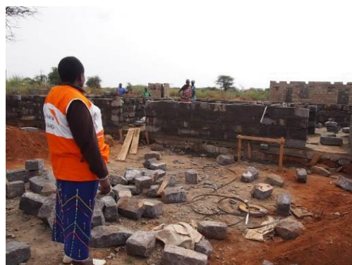
スタッフ宿舎の建設
