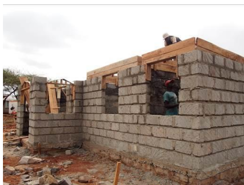
産科棟の建設
