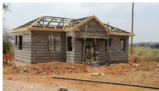
スタッフ宿舎の建設
