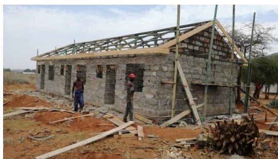
産科棟の建設
